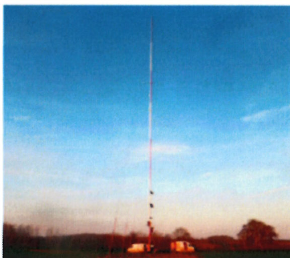
Mât de mesure installé à Cartigny en janvier 2020
